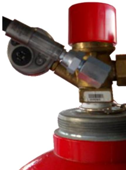
10. Attacher le flexible pneumatique *master* (pilote) au déclencheur pneumatique réservoir piloté (adaptateur fourni). **Voir manuel FSL.**
